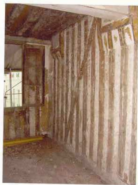
Fig. 6 : maison du 293 rue de Bourgogne : deuxième étage du corps de bâtiment antérieur, mur-pignon mitoyen oriental : pan-de-bois avec linoirs sur poteaux à têtes élargies portant les poutres du plafond. Emplacement du cabinet de travail, à l'angle formé avec la façade : traces de peinture rouge foncé sur la paroi.
