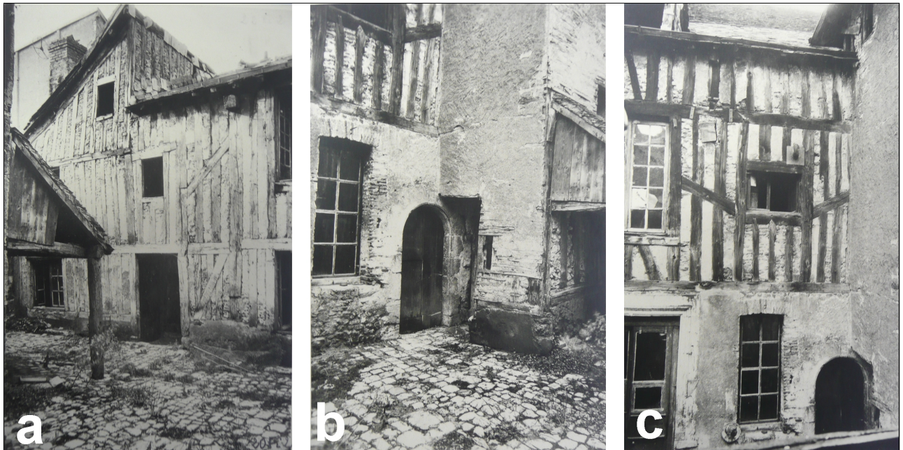
FIGURE 25 – Orléans, maison 1 rue Jean-Calvin : photographies de la façade sur cour des bâtiments occidental (a) et oriental (b et c), vers 1930-1941 (Arch. dép. Loiret, 7 Fi 140/1-3) (cliché C. Alix).
