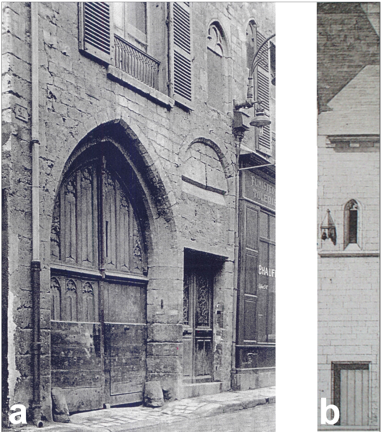
FIGURE 12 – Orléans, baies à linteaux ornés d'un arc brisé à trilobe, façades antérieures de maisons (2 e moitié XIII e – XIV e siècle). a : maison dite du Cheval-Blanc, anciennement rue Sainte-Catherine (Musée historique et archéologique de l'Orléanais, Inv. 2990) ; b : maison anciennement 8-10 rue Neuve (dessin de L. Vaudoyer vers 1845), publié dans BAUDOT, PERRAULT-DABOT 1856, pl. 86 (cliché C. Alix).
