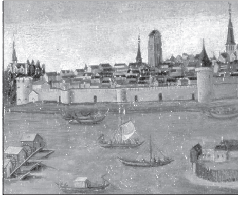
FIG. 25 : Détail du front de « la turcye Saint-Laurent », d'après le plan dit des Échevins (xvi e siècle ; MHAO Inv. A 6924). On observe de gauche à droite : la grosse tour Saint-Laurent, la tour Roze et la tour de Recouvrance. A droite, la tour du Bassin marque la jonction avec la « deuxième enceinte ». Cl. François Laugnie - Musée des Beaux-Arts d'Orléans.
