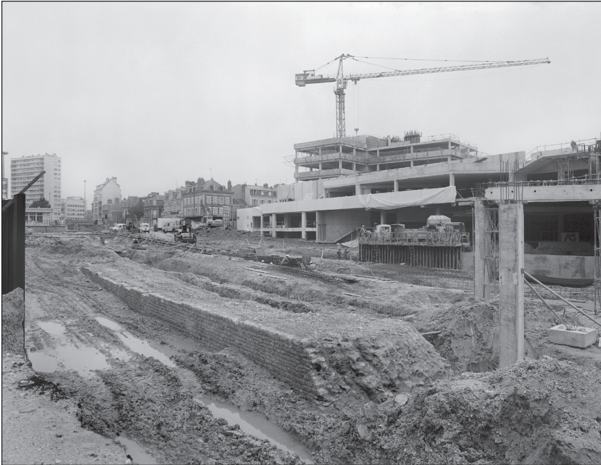
FIG. 22 : Vue du parement interne de la courtine située sur le front entre les portes Saint-Vincent et Saint-Poir, découverte lors des travaux d'aménagement des boulevards de Verdun et Alexandre-Martin (1987). Cl. Robert Malnoury © – Inventaire Général Centre, 1987 – ADAGP.
