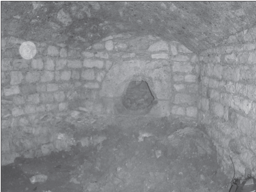
FIG. 14 : Détail de l'embrasure de tir orientale du niveau d'entresol de la porte Saint-Poir. Cl. Clément Alix.
