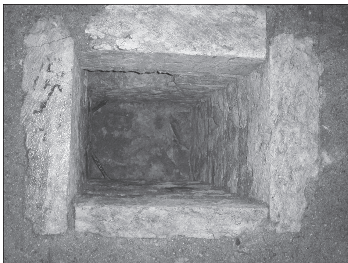
FIG. 12 : Trémie percée dans la voûte de la tour orientale de la porte Saint-Poir. Cl. Clément Alix.
