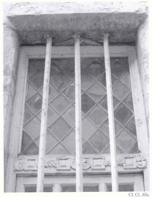
Fig. 5 - Orléans, Maison 12, rue des Trois-Maries. Châssis de vantail à corps de moulures extérieur et traverse sculptée de motifs géométriques classiques, milieu XVI e siècle (fenêtre rectangulaire du rez-de-chaussée, façade antérieure).
