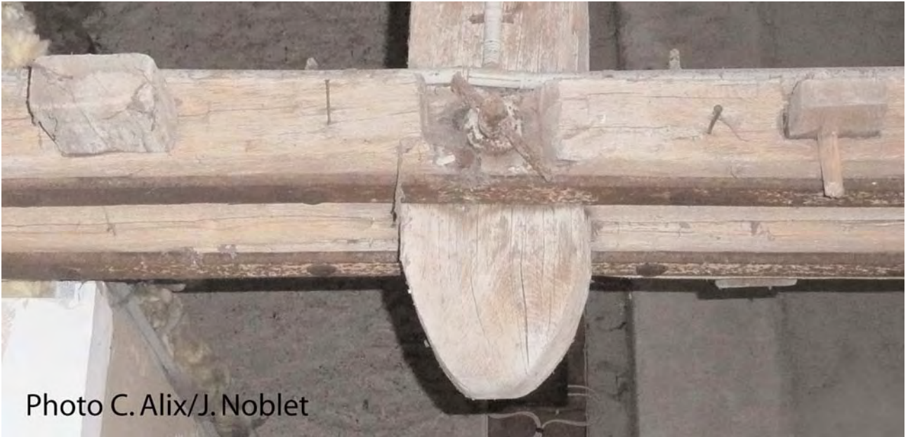
Fig. 20 : Manoir de la Fosse-Belaude à Saint-Jean-de-Braye (2 e moitié du XVI e s. ou début du XVII e s.) : clefs traversantes et boulon d'écartement.
