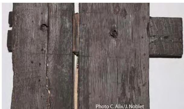
Fig. 17 : Maison 25bis rue de l'Ange/59 rue des Carmes milieu du XVI e s.) : clef traversante maintenue par deux chevilles.
