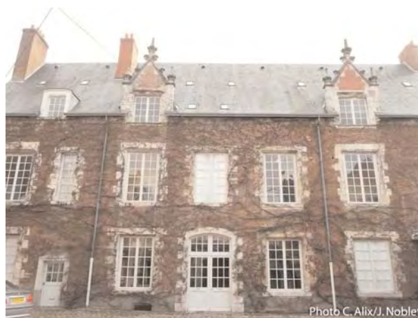
Fig. 4 : Maison du roi Louis XI, 10 cloître Saint-Aignan : façade occidentale.
