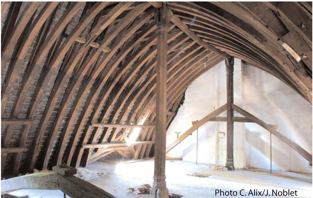
Fig. 29 : Hôtel de François Brachet, dit de la Vieille-Intendance, 24-28 rue de la Bretonnerie : corps de bâtiment principal, charpente à chevrons-formant-fermes en forme de voûte, vue vers l'est (vers 1505d)
