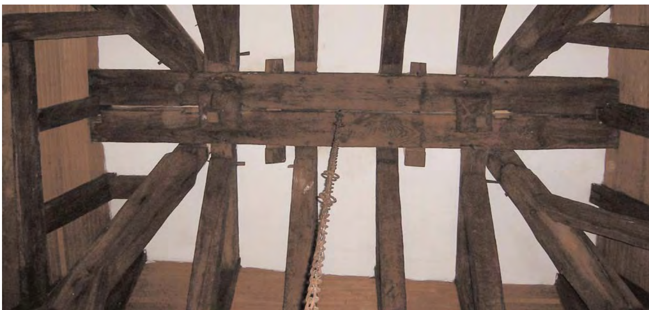
Fig. 26 : Hôtel de François Brachet, dit de la Vieille-Intendance, 24-28 rue de la Bretonnerie : tour d'escalier orientale du corps de bâtiment principal (vers 1505d) : charpente en pavillon avec entrain retroussé moisé maintenu par des clefs traversantes, poinçons pendants (Cl. : C. Alix et J. Noblet).
