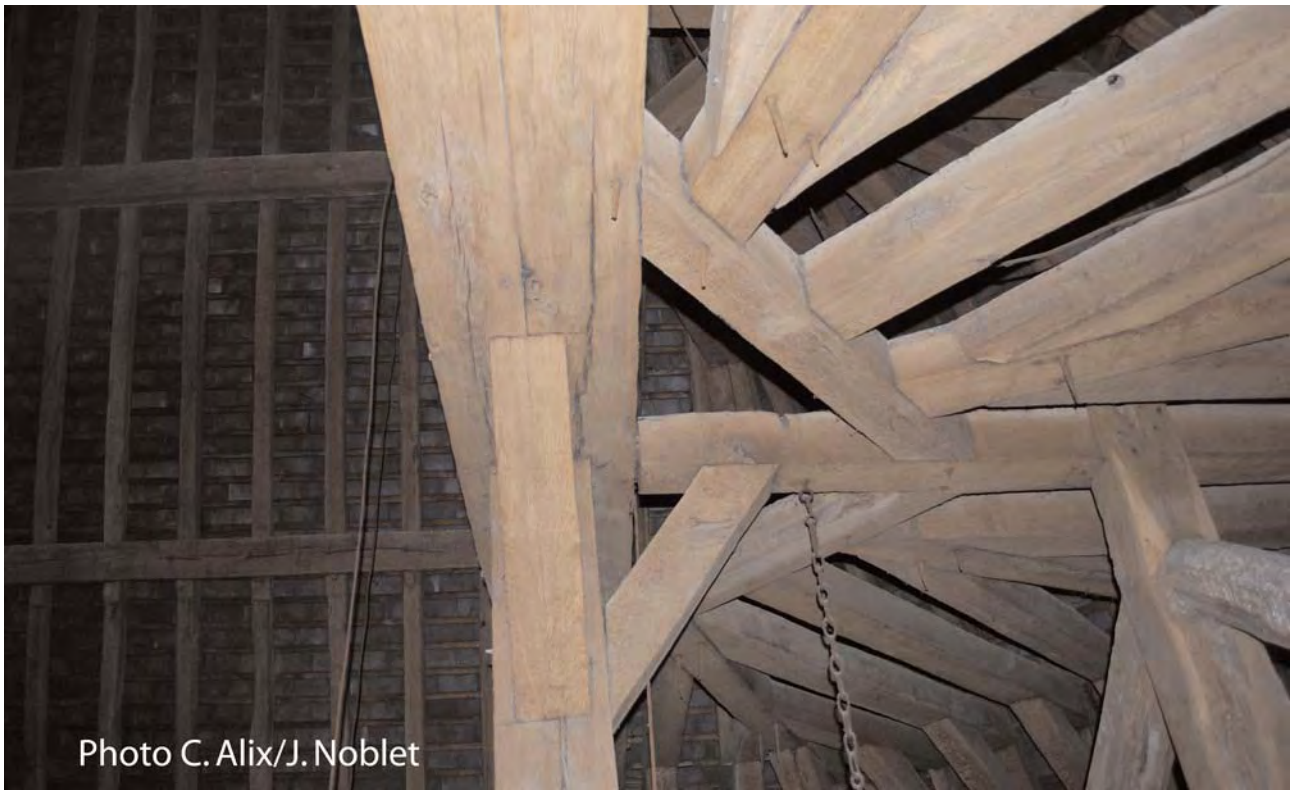
Fig. 28 : Église collégiale Saint-Aignan : ferme du chevet : 1 er niveau d'enrayure.
