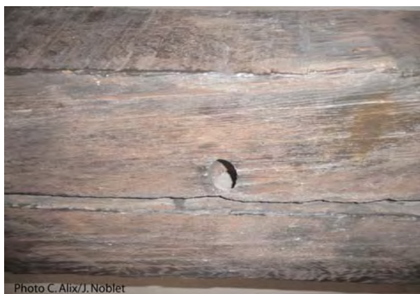
Fig. 15 : Maison 10 rue des Trois-Clefs (milieu ou 2 e moitié du XVI e s.) : ferme occidentale : perforation oblique, traces de scie de long.
