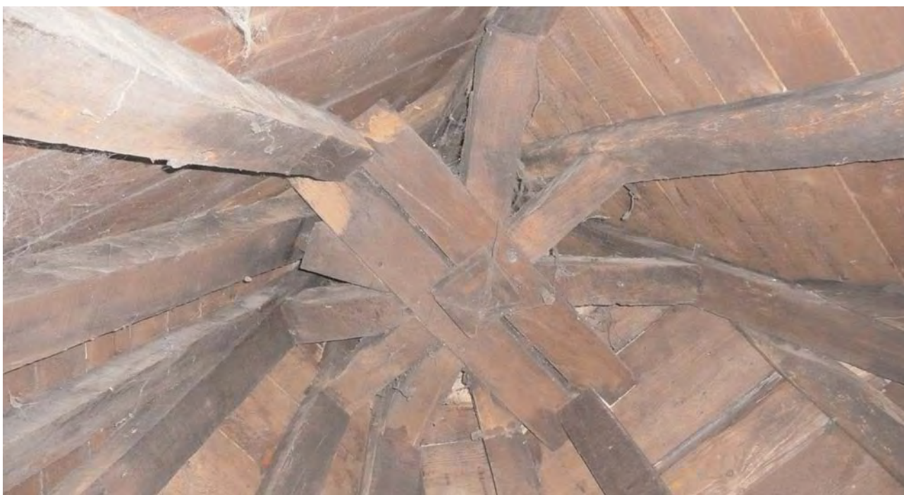
Fig. 25 : Maison 22 rue du Poirier (2 e moitié du XVI e s.) : charpente de la tourelle d'escalier en pan-de-bois : enrayure supérieure avec entrait retroussé moisé (Cl. : C. Alix et J. Noblet).
