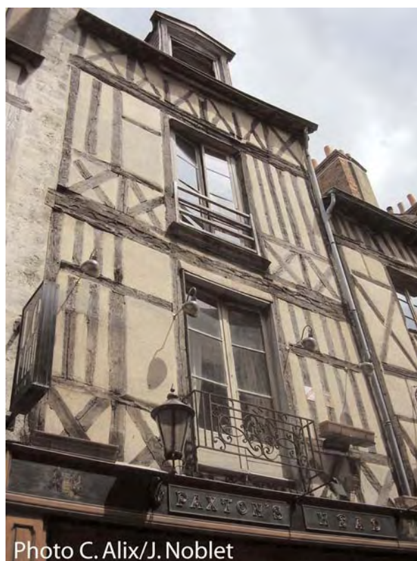
Fig. 23 : Maison 266 rue de Bourgogne : façade antérieure, entre 1473 et 1488d, surmontée d'un comble dont la charpente est reconstruite en 1516d.
