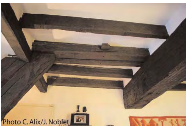
Fig. 24 : Maison 25 bis rue de l'Ange/59 rue des Carmes (milieu du XVI e s.) : plancher inséré au niveau de l'entrait retroussé moisé.
