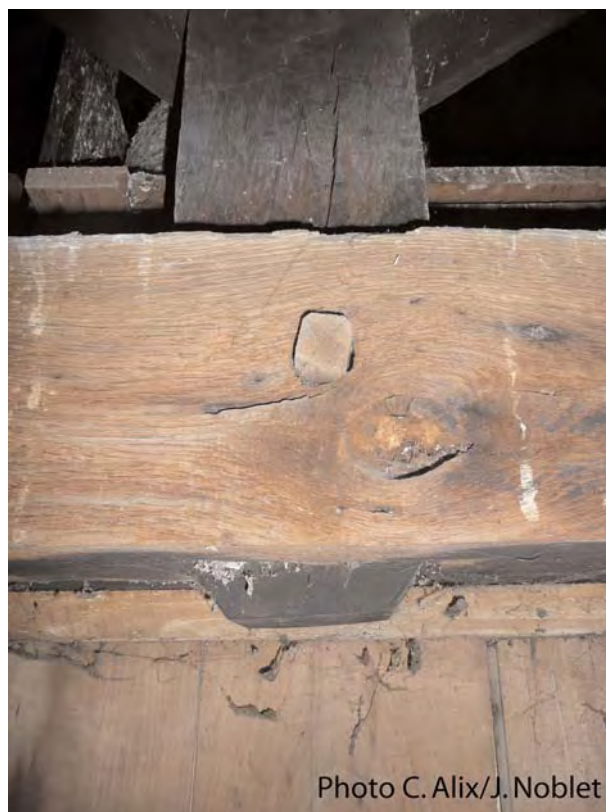
Fig. 18 : Maison 266 rue de Bourgogne (1516d) : cheville en bois bloquant l'assemblage entre l'entrait retroussé moisé et le poinçon.
