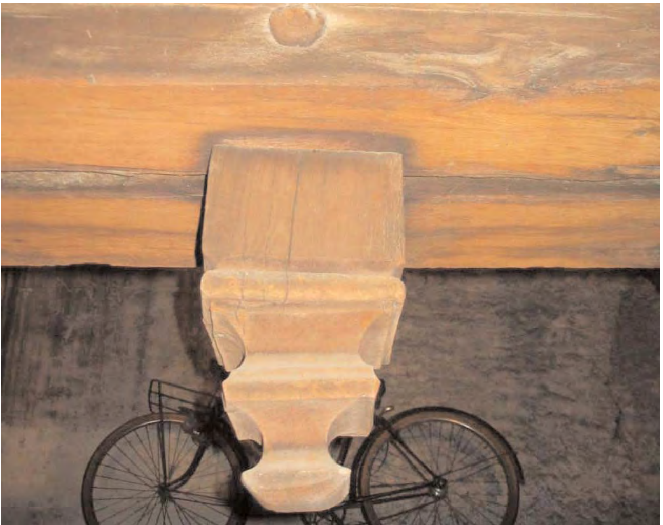
Fig. 21 : Maison canoniale du quartier cathédrale 6 place du Cardinal-Touchet (fin XV e ou début du XVI e s.) : poinçon pendant mouluré et tête du boulon d'écartement (Cl. : C. Alix et J. Noblet).
