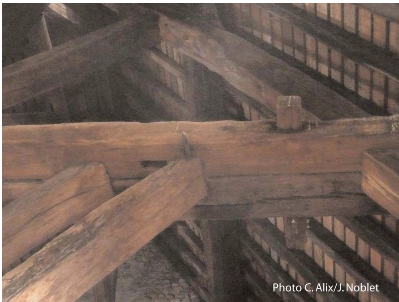
Fig. 3 : Salle des Thèses, 2 rue Pothier (1420-1421d) : extrémité occidentale de l'entrait retroussé moisé maintenu par une clef en bois ; " cheville en fer " dans la tête du lien ajouté au XVI e s.
