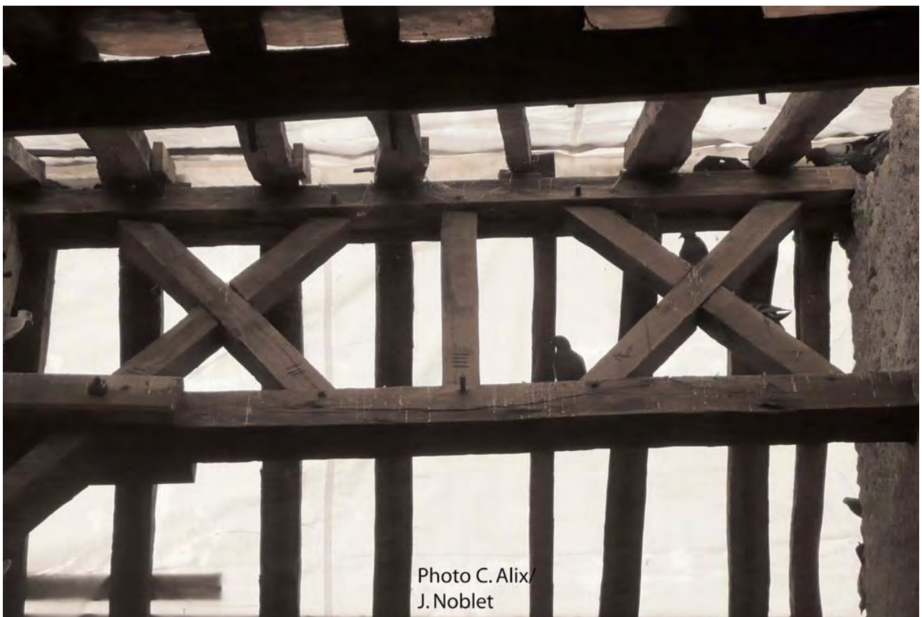
Fig. 10 : Maison dite de la Coquille, 7 rue de la Pierre-Percée (vers 1543-1544d) : partie orientale du contreventement, vue vers le nord.
