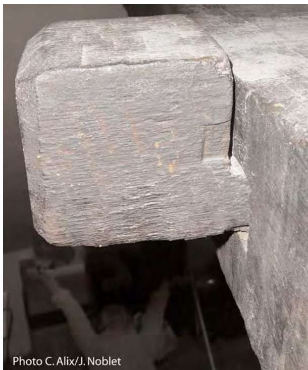
Fig. 16 : Maison 10 rue des Trois-Clefs (milieu ou 2 e moitié du XVI e s.) : clef traversante de l'entrait retroussé moisé (Cl. : C. Alix et J. Noblet).
