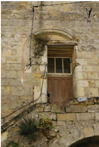
a. Fenêtre à baie gémée sur le mur septentrional.
