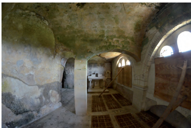
Vue générale de la chapelle depuis l'ouest
