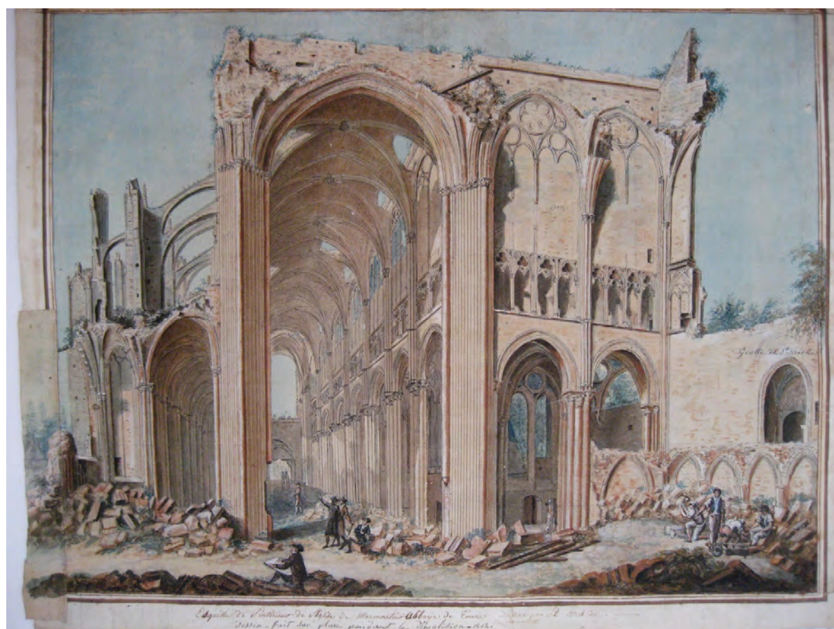
b. L'église abbatiale en cours de démolition, vue de la nef et du transept , aquarelle de Morillon (SAT, 1802)
