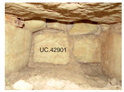
f. Bouchage du conduit d'évacuation à l'époque moderne.
