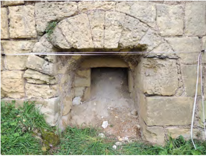
a. Vue générale de la baie avant déblaiement et fouille
