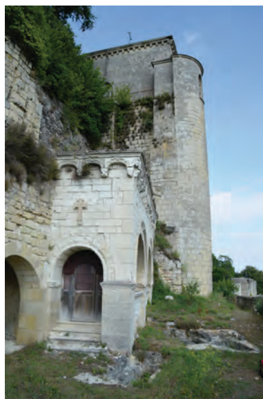
b - vue depuis l'ouest de la partie orientale de l'espace 1
