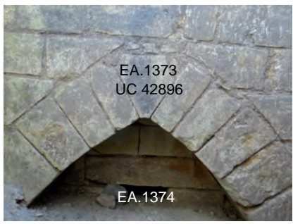
d. Arc de décharge surmontant le conduit d'évacuation.
