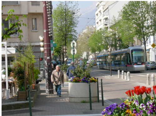
Avenue Maréchal Randon Contrainte aménagée et vie de quartier
