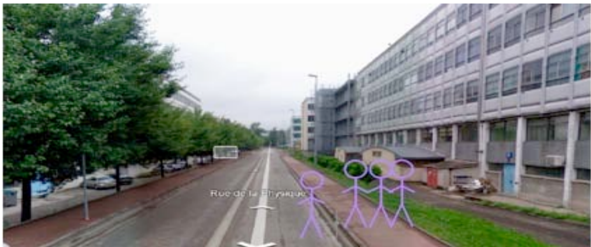
figure 10 : exemple de trottoirs trop hauts (ALBINET et alii , 2010)
