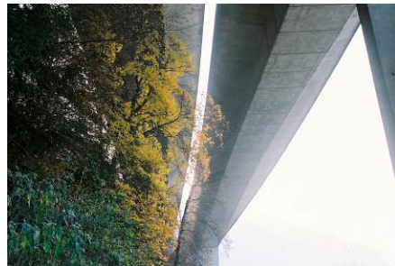
Illustration 4 Le caractère aérien et la pureté des tabliers de l'ouvrage d'origine
