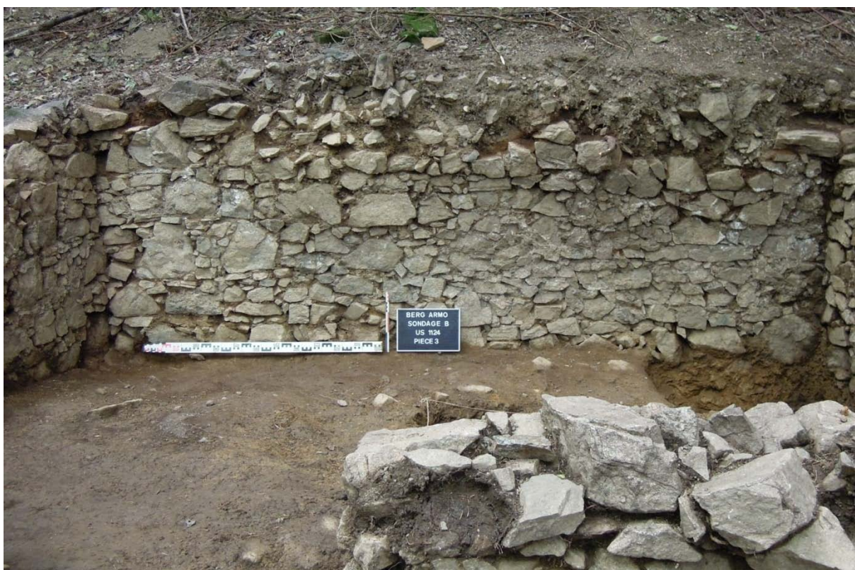
Pièce 3, parements internes des murs est ou mur 1 (en haut, vue vers l'est, remarquer l'ancienne porte) et sud (en bas)
