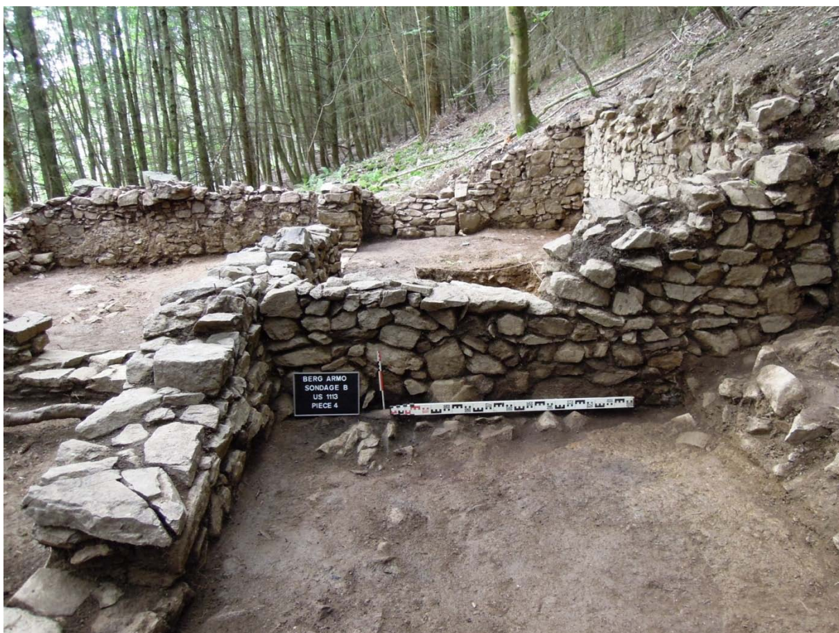
Le mur de refends entre les pièces 3 et 4, vu vers l'ouest (en haut) et l'est (en bas)
