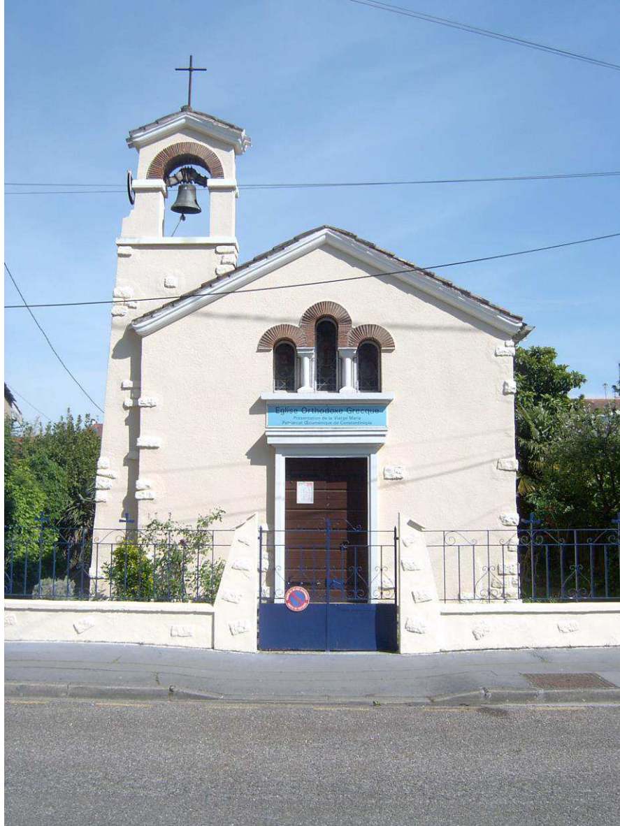
(vue de la façade nord de l'église, repeinte couleur blanche « ton pierre », en 2008)
