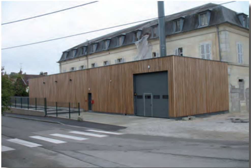
Photo 1 : chaufferie bois de Lons-le-Saunier ; crédit photo, ville de Lons-le-Saunier
