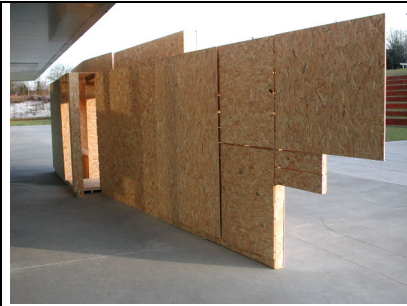
Registre lisse sur la face coulisse derrière l'écran /abri
