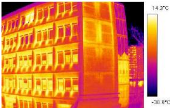
Diagnostic d'isolation thermique
