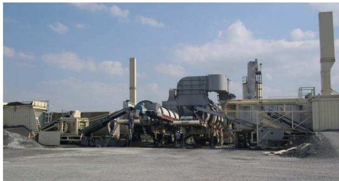
**Figura 2.** Central de mistura asfáltica com dois tambores separados modelo Benninghoven (campo de reciclagem a taxas elevadas em um EME em autopista no norte da França)
