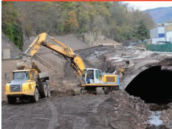
DESTRUCTION DE LA ROUTE. 10 NOVEMBRE 2009
