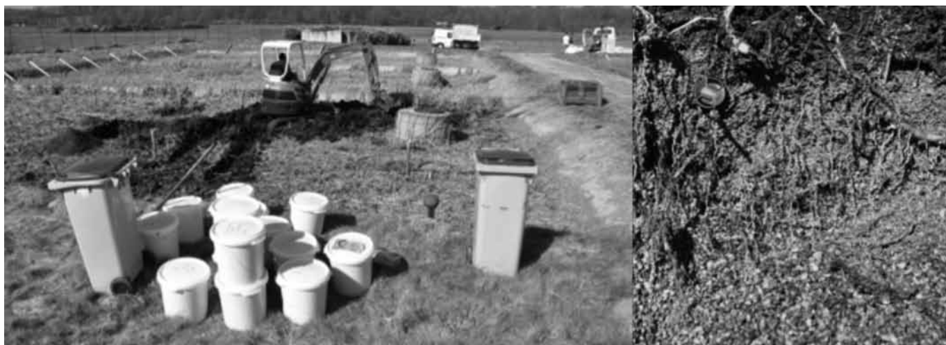
Figure 3 : Prélèvement des boues sur la station d'épuration de Vercia (Jura) en période hivernale. Vue générale (à gauche) et vue en coupe (à droite) d'une tranche de prélèvement montant la couche de boues en surface
