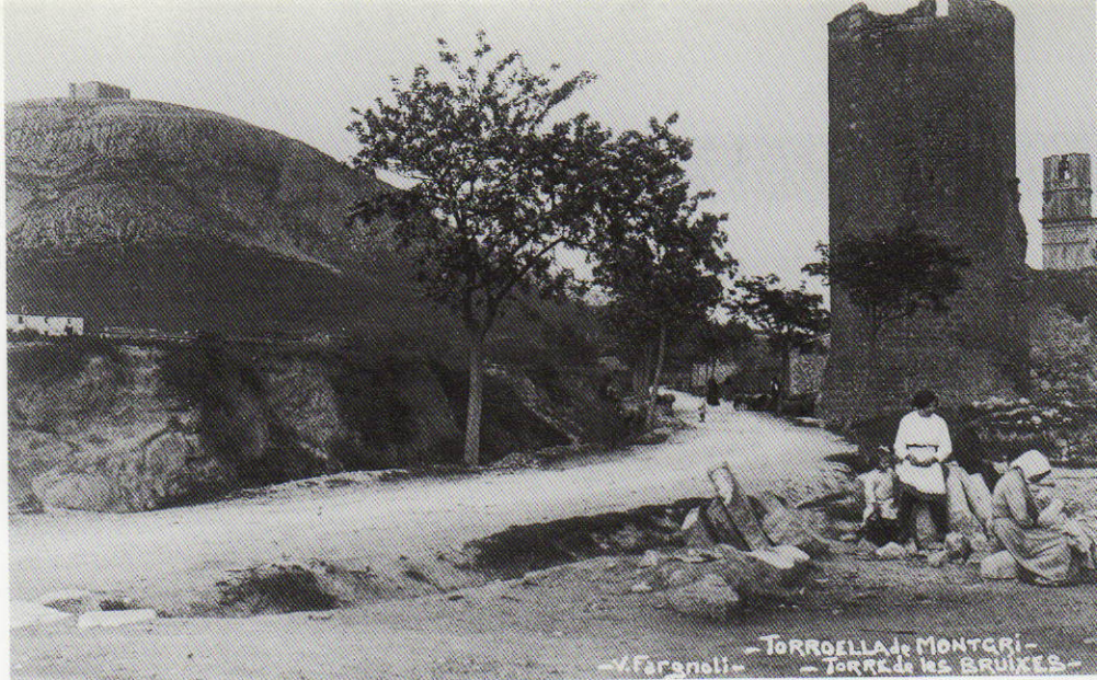
Torroella de Montgrí es va protegir contra els pirates amb fortificacions.
