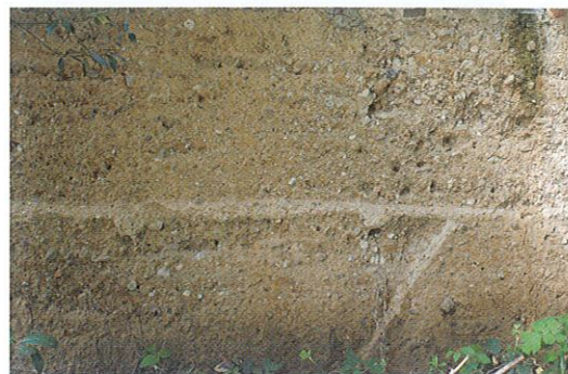
↓ Mur de clôture en pisé
