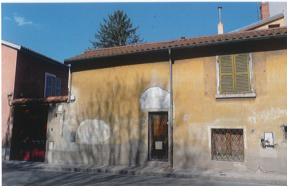
↓ Quartier Saint-Just, Construction en pisé sur l'avenue Barthélemy Buyer
