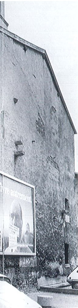
←↑ 3 rue de Trion, état de l'immeuble en 1981 et aujourd'hui. L'immeuble a subi peu de modifications, il a été ré-enduit, de sorte que le pisé n'est plus visible.
