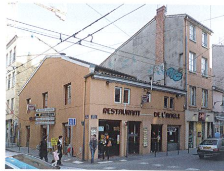
↙↑ La grande rue de la Croix-Rousse dont les petites maisons mitoyennes, assez basses, de 2 à 3 niveaux, sont souvent construites en pisé.
