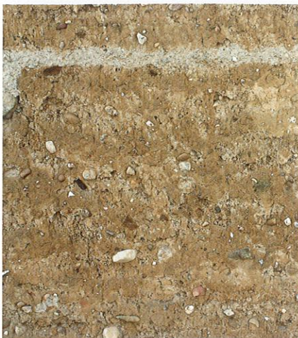
↓ Détail de texture d'un mur en pisé, Lyon
