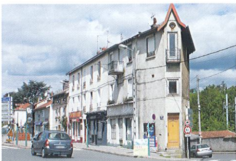
↑↘→ Vue de la place, angle Nord-Est et détail sur pisé
