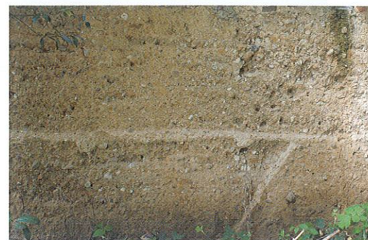
↓ Mur de clôture en pisé
