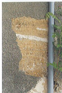
↑ Détail de l'îlot au 60 de l'avenue V. Hugo
