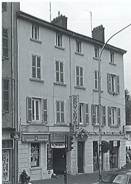
↑ Tassin, 53, rue de la République, un immeuble de 4 niveaux en pisé aujourd'hui démolì.
