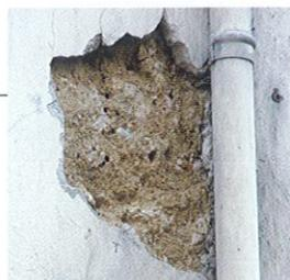
←↑ Le pisé apparaît sous l'enduit dégradé au N°34
