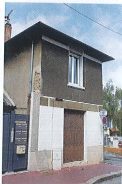
↓ La façade sur rue masque un pisé (visible sur l'angle Est), et, en fond de cour, est visible un mur en mâchefer.
