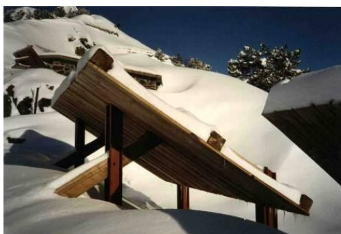
Figure 7. Toits buses en crête du couloir du Theil RTM de Barèges (ONF-RTM 64-65).
