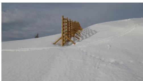
Figure 5. Auris-en-Oisans_ Barrière à neige avec son dépôt de neige sous vent de Nord-Ouest (ONF-RTM 38, déc 2012)
