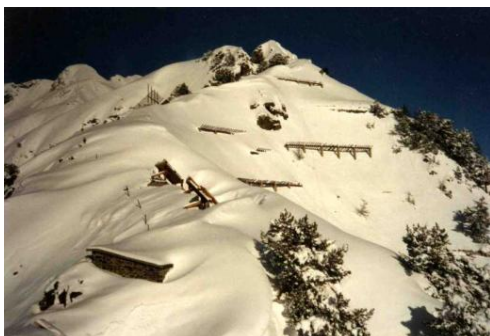
Figure 11. Toits buses et leur sillage dans le manteau neigeux en marge du couloir du Theil équipé en lignes de râteliers.
