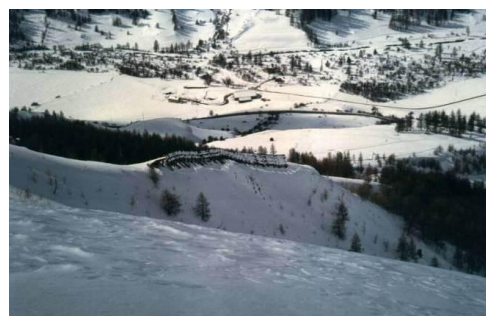
Figure 8. Alignement d'ouvrage à vent (pupîtres P à droite et toits-buses à gauche) en crête orientale du couloir du Combal - Larche (cliché RTM 04).
