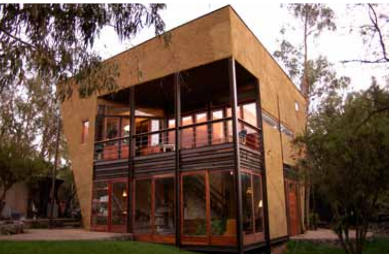
Image 6 : Construction en ossature métallique et torchis réalisée par l’architecte chilien Marcelo Cortes. © M. Cortes
