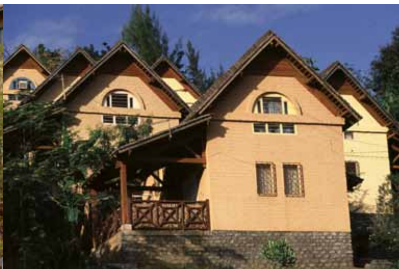
Image 2 : Habitat locatif à Mayotte construit par la SIM. © CRAterre, T. Joffroy
