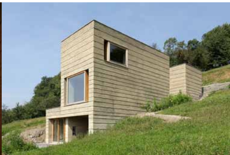
Image 4 : Maison du constructeur Martin Rauch à Schlins en Autriche. © M.Rauch
