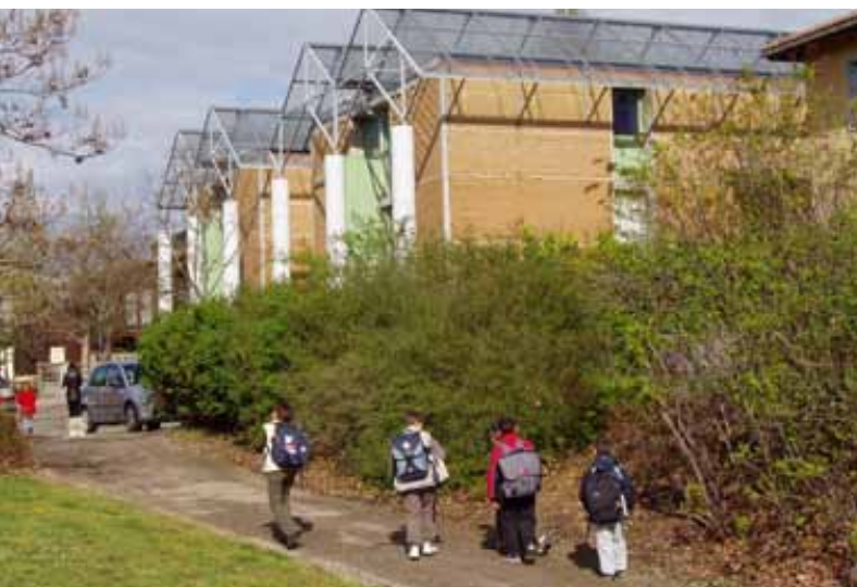
Image 1 : Le village terre à Villefontaine, projet des architectes Jourda et Perraudin. © CRAterre, T. Joffroy
