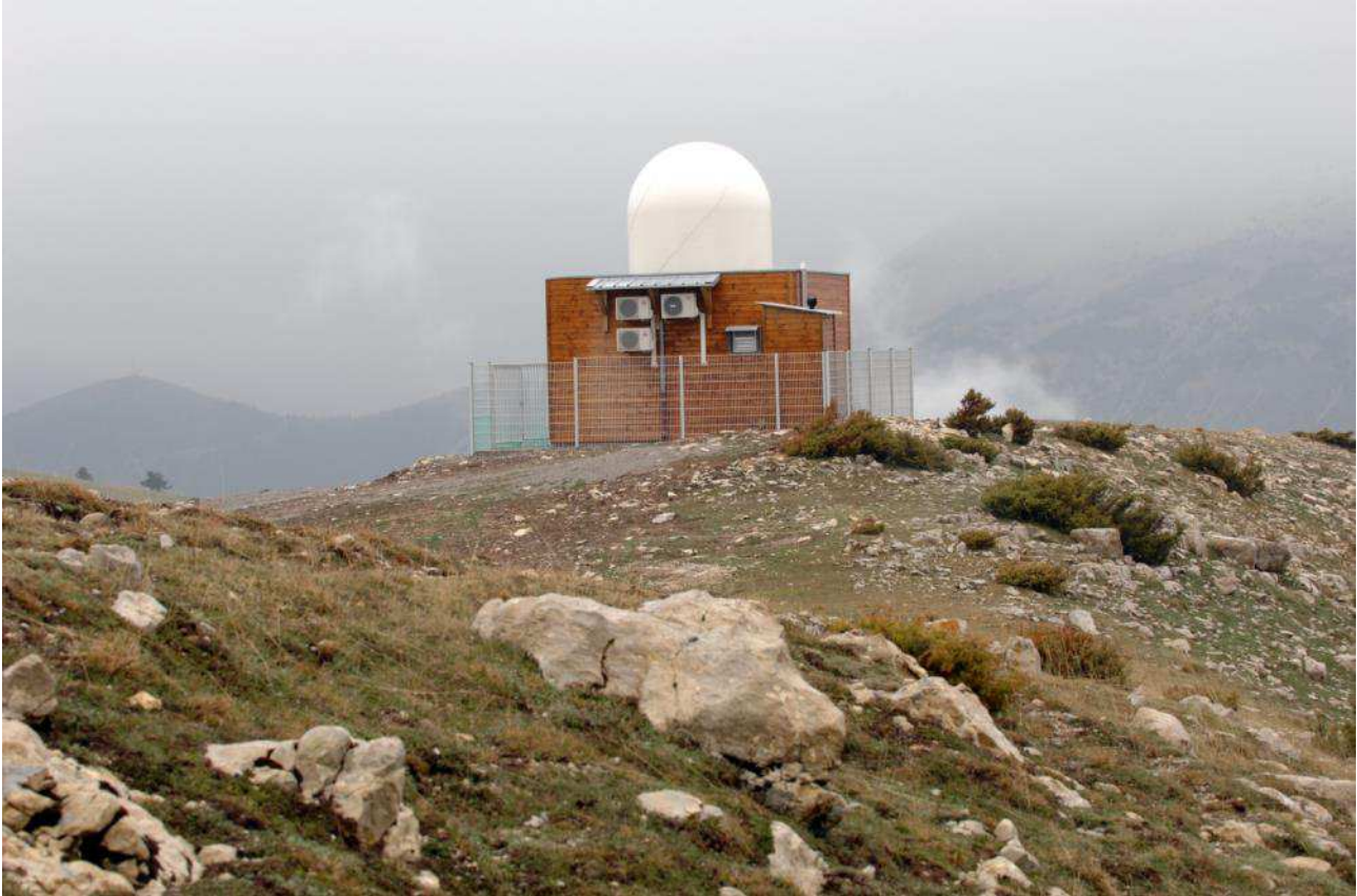
Figure 1. Installation radar au sommet de la montagne Maurel à 1779 m (altitude du faisceau radar), sur la commune de La Mure-Argens dans les Alpes-de-Haute-Provence. ©Météo-France, Pascal Taburet.
