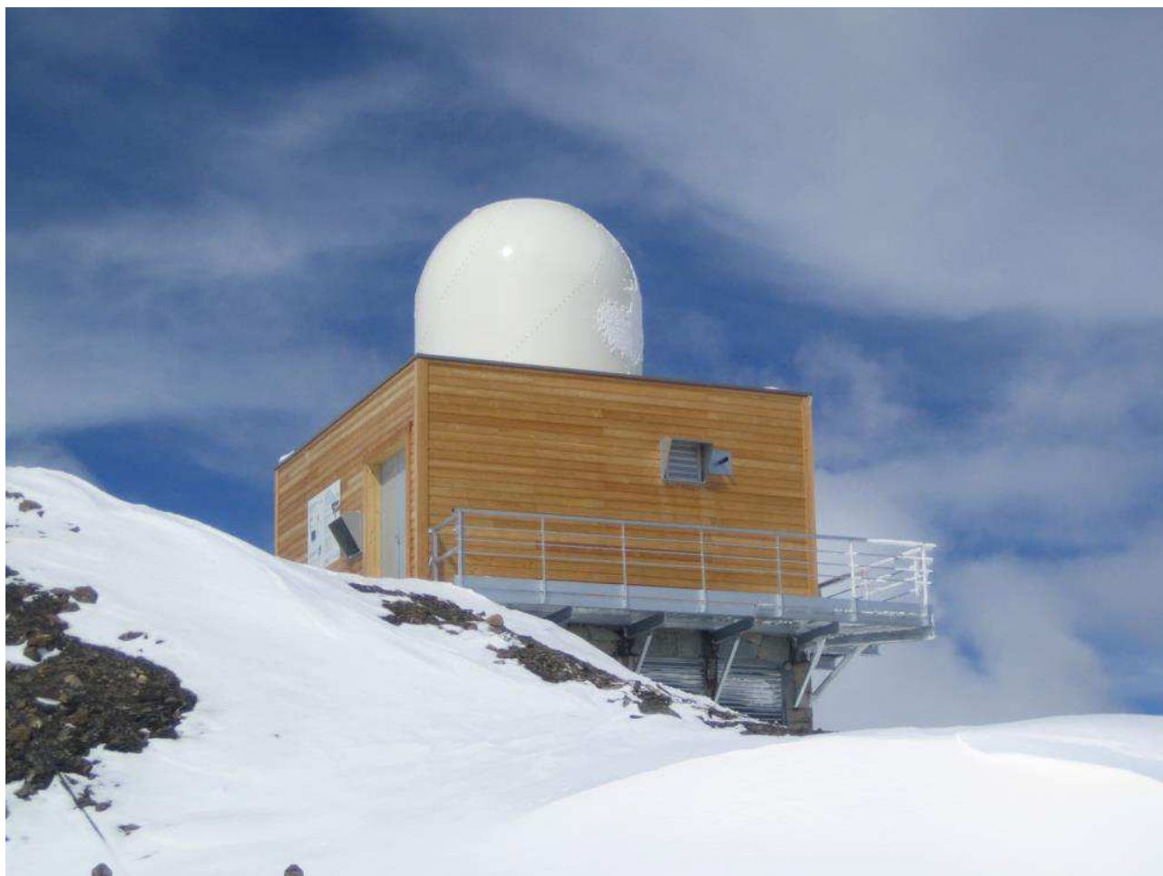
Figure 3. Installation radar au sommet de Vars Mayt à 2581 m (altitude du faisceau radar), sur la commune de Vars dans les Hautes-Alpes. ©Météo-France, Yves Clémenceau.
