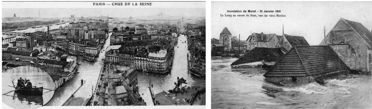
Figure 1 : Inondations de janvier 1910 : (a) perspective depuis la tour de l'horloge Gare de Lyon à Paris (29 janvier) ; (b) Loing à Moret-sur-Loing (source : crue1910.fr).
