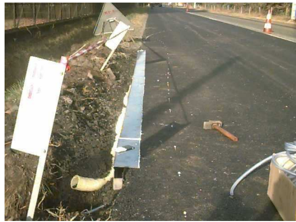
installation de la goutte avec drain
