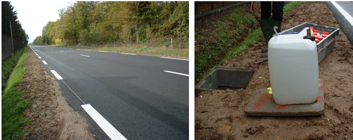
Figure 37. Récupération de l'eau sur le site RN76
