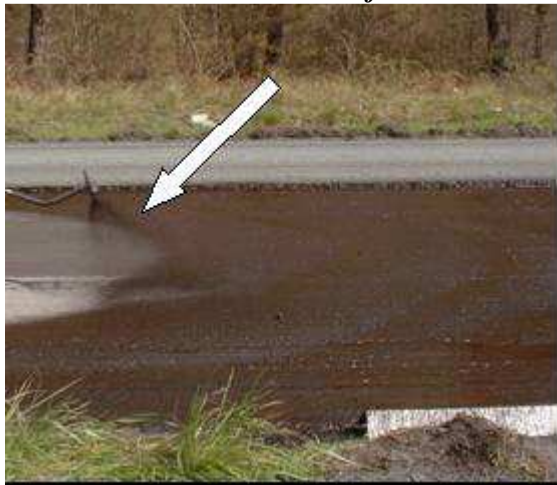
c : Mise en place de la couche d'accrochage
