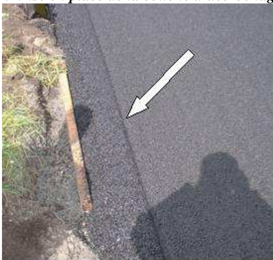
e : Compactage de l'enrobé
