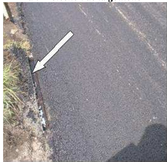
f : Goulotte mise en place
