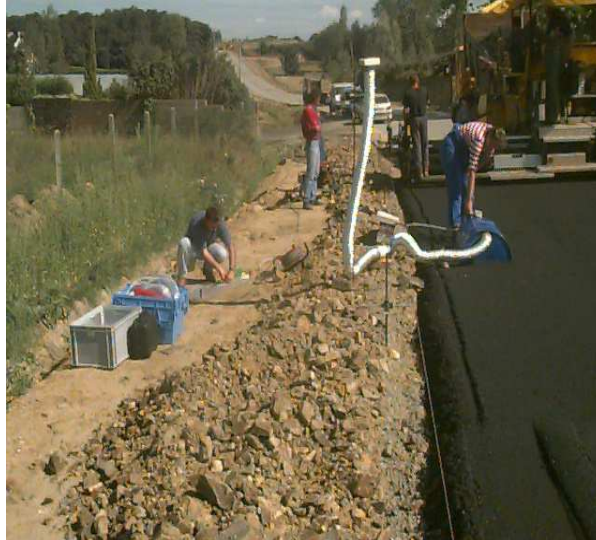
Figure 10. Mesures préliminaires avec le capteur, après répandage de l'enrobé.
