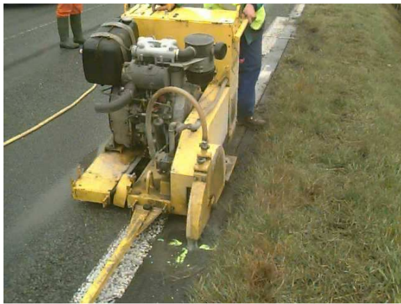
Sciage en rive de chaussée
