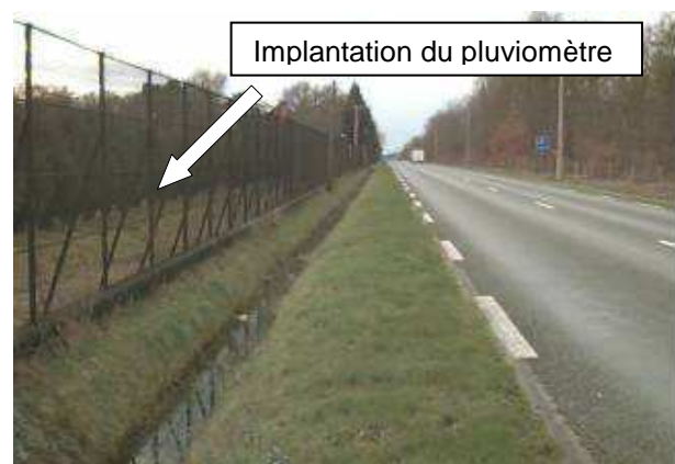
b) lieu d'implantation du pluviomètre
