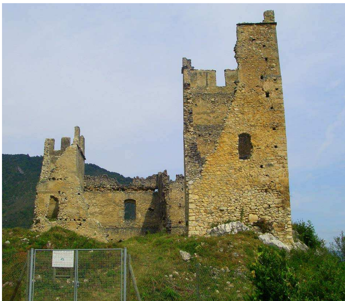
Fig 9 : Fichier IMG0386. Titre : Le réduit fortifié du XIVe siècle. A droite, le donjon, à gauche, la tour de la citerne. Photo Florence Guillot.
