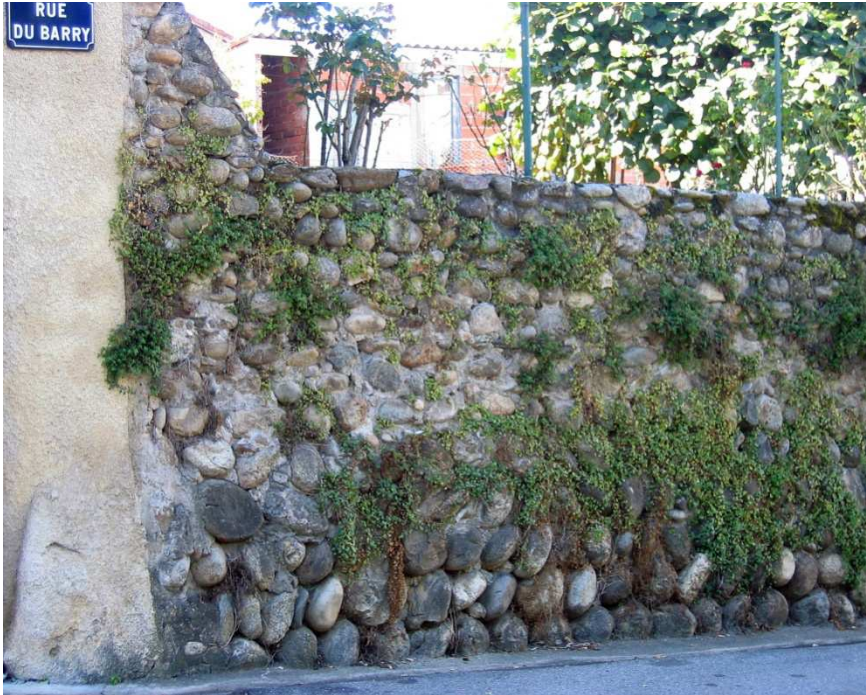
Fichier varilhes.jepg. Légende : Vestiges du mur d'enceinte du quartier Saint-Michel à Varilhes (les quatre premières assises, le reste est plus récent). Photo Dorian Boyer.
