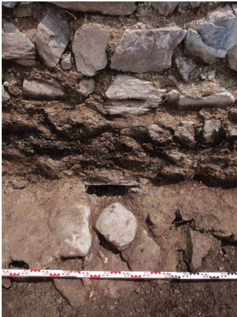
Evacuation de l'eau au pied du M 70. Photo F. Guillot.
