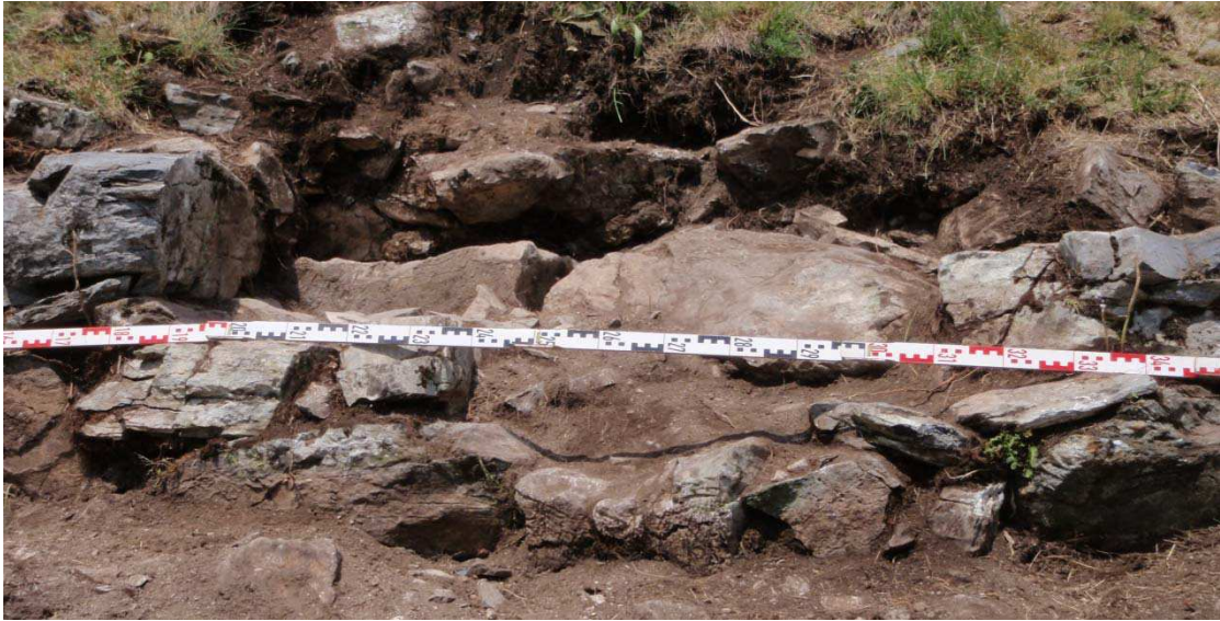
Petit seuil (A8) de poterne dans le parement externe du M 71. Photo F. Guillot.
