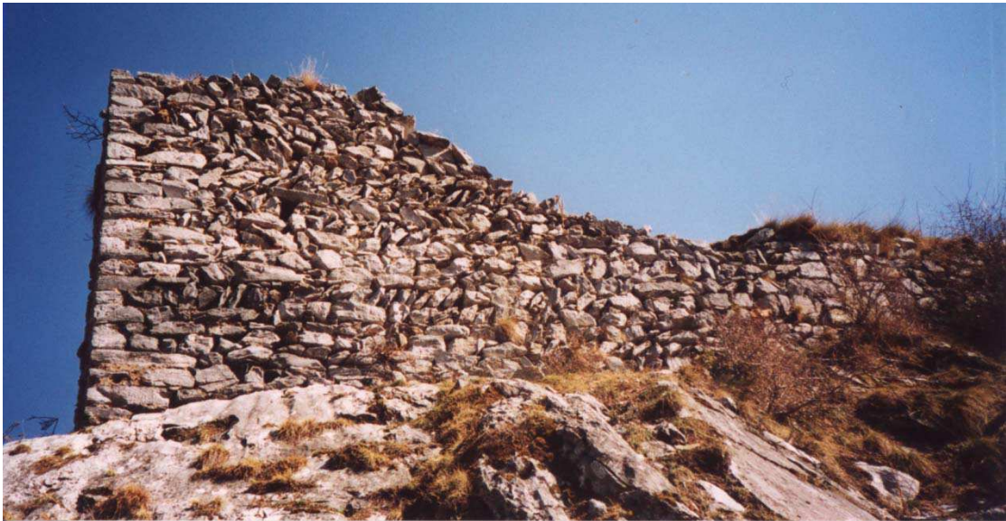
Tour du barri. Parement externe nord-ouest. Photo Florence Guillot.
