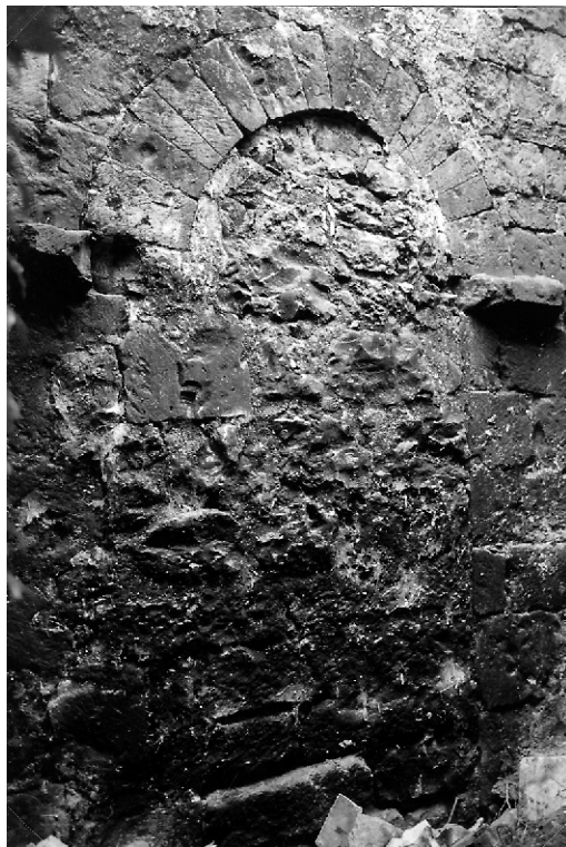
Fig. 5 - vestiges du premier état du mur gouttereau nord de l'église priorale (cl. B. Véquaud).
