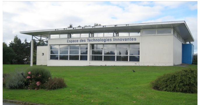
Fig. 4. “Espace des Technologie Innovantes” in Rennes, France.
