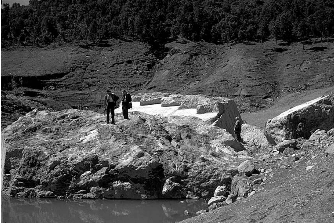
Fig. 4. Les deux principaux blocs de béton, à l'amont du second coude de la vallée (larges de 13 m épais de 6 à 7 m et hauts de 8 à 10 m, ces bases des deux plots du bas de la rive gauche pèsent donc chacun plus d'un millier de tonnes) ; au premier plan, le rocher est identifié par sa couleur sombre alors que le béton est clair (photo J. Duffaut, 20 décembre 1959).
