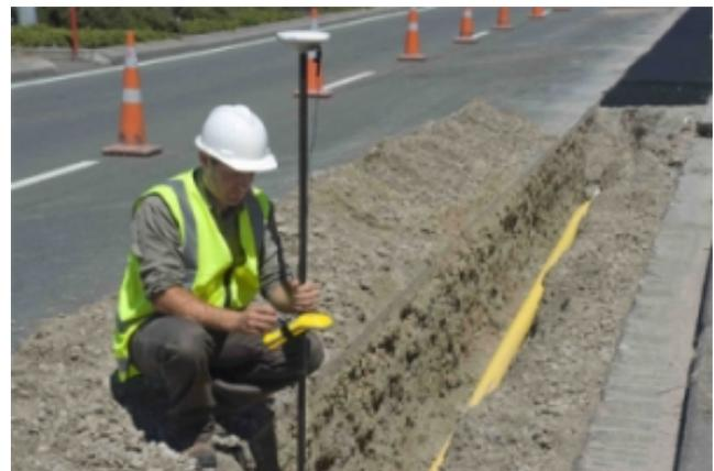
Figure 4: Lever d'un point d'un fourreau avec une canne GPS, ancrage sur réseau de la cellule correspondante sur Capitole, point d'ancrage choisi en vert.
