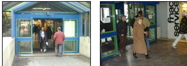
Figure 1. Sas composé par un double système de portes automatiques. Centre commercial Grand Place, Grenoble Sud
