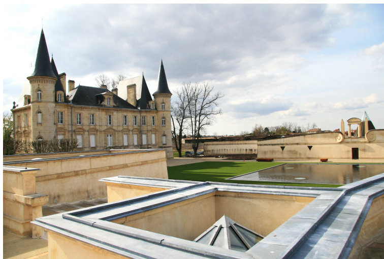
Photo. n° 1 : Le nouveau chai du Château Pichon-Longueville, une réinterprétation du néo-classicisme de l'Époque Moderne. Cliché R. Schirmer, 2008.
