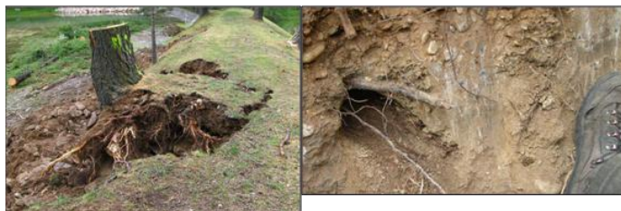
Figure 1. Mécanismes d'érosions externe (à gauche) et interne (à droite) associés à la présence d'arbre sur un ouvrage hydraulique. A droite : galerie liée à la décomposition d'une racine dans des matériaux à matrice limoneuse cohésive. (Photo : Irstea - C. Zanetti)
