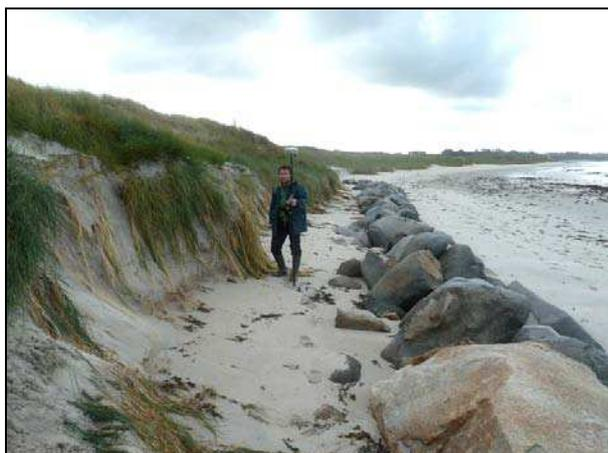
*Photo 1. Falaise d'érosion et recul de la dune à l'arrière de l'enrochement de la plage du Curnic (Vougot) – 18/10/2012*
