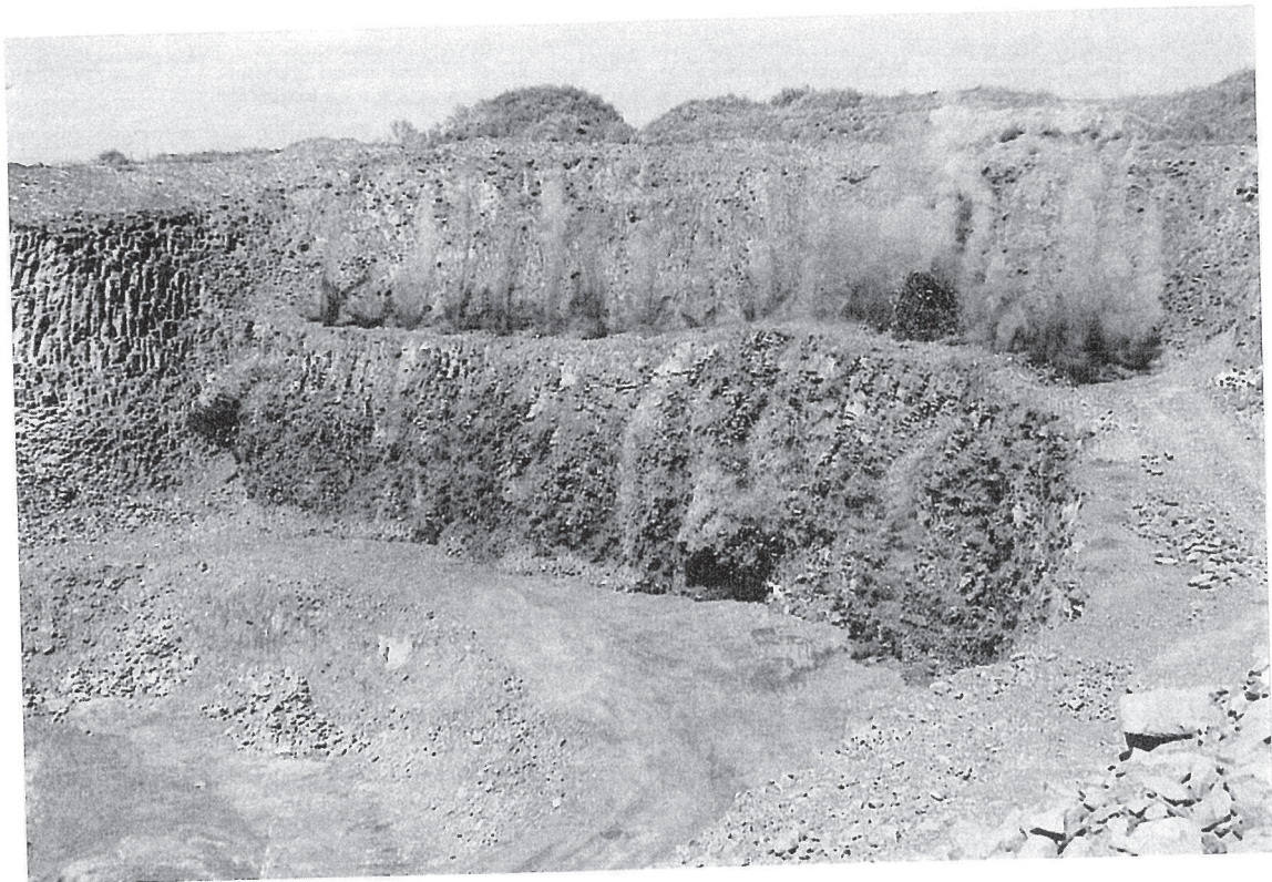
Figure 28 – débouillage des trous liés à l'amorçage latéral de sécurité (double amorçage) réalisé au cordeau détonant. A noter les panaches de gaz à grande vitesse et l'éjection du bourrage (éléments gris à la base des colonnes).
