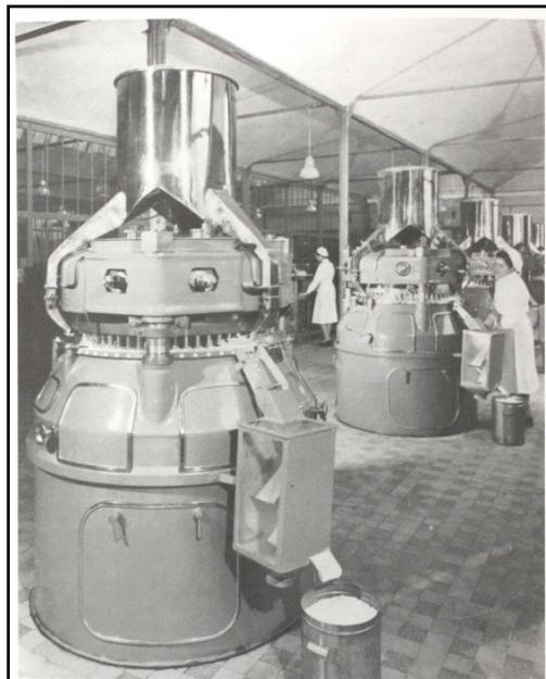
**SPECIA Saint Fons (1950) Atelier Aspirine équipée de machines à comprimer dite Viennoise fabriquées par Rhône Poulenc, avec 3 postes de compression, 180 000 comprimés/h**
