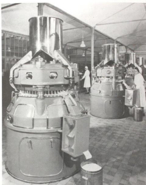
**SPECIA Saint Fons (1950) Atelier Aspirine équipée de machines à comprimer dite Viennoise fabriquées par Rhône Poulenc, avec 3 postes de compression**
