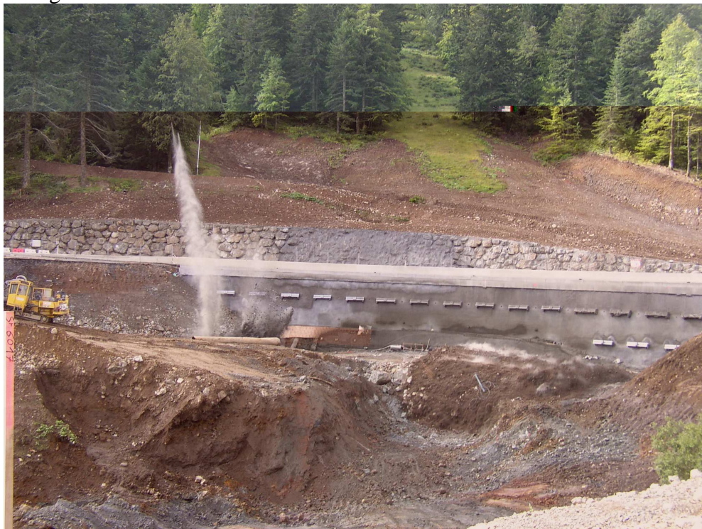
Fig 11 : tir affecté d'un « effet canon » au niveau d'un trou de la volée
