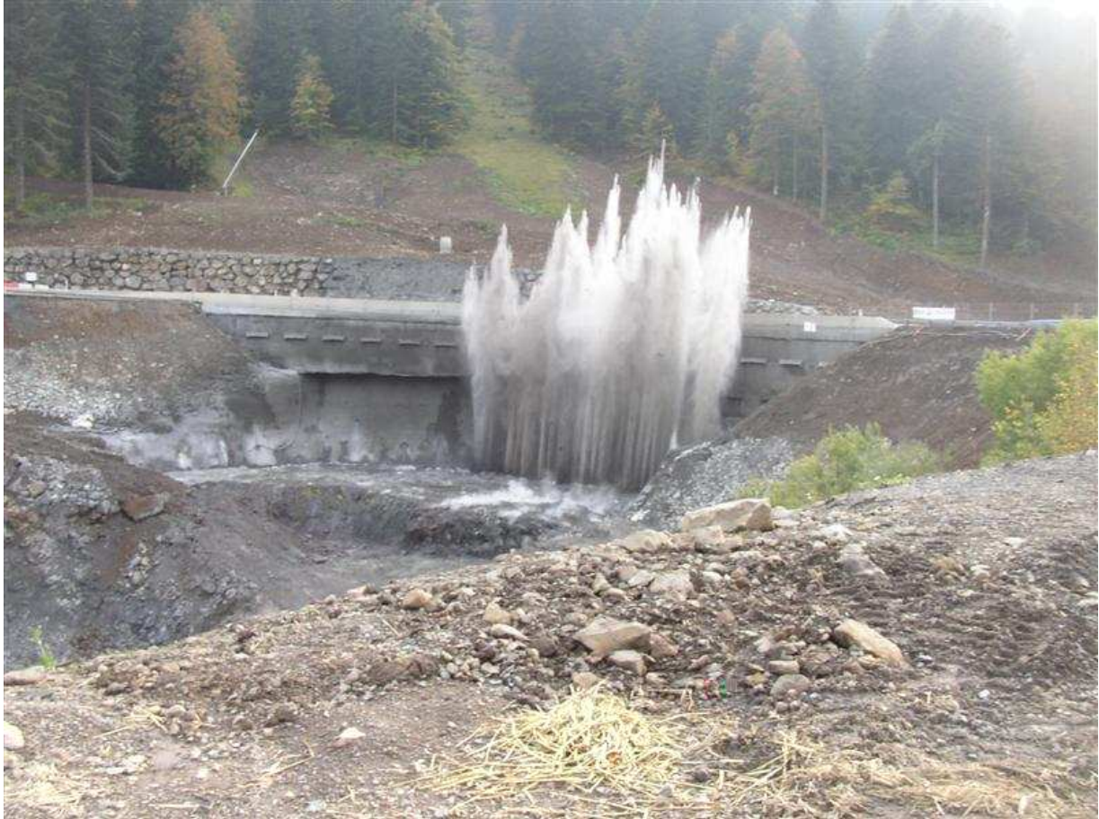
Figure 9 :. Tir de découpage provoquant l'émission de gaz à grande vitesse dans l'atmosphère matérialisée par les colonnes étroites des projections émanant de chaque trou.
