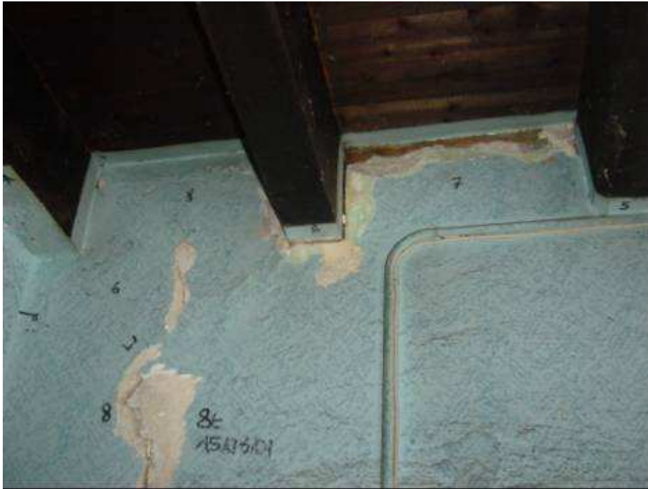
Figure 21 :. Chutes de plâtre et d'enduit au contact poutre-cloison sur un bâtiment soumis à des tirs de forte intensité.
