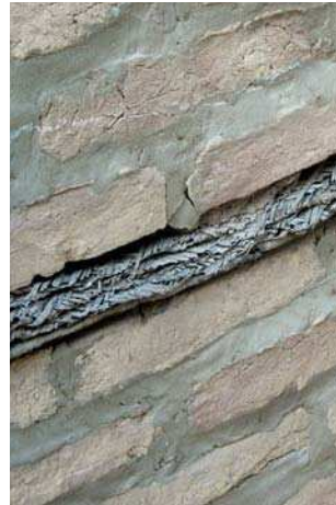
Ouzbekistan roseaux dans maçonnerie adobe système parasismique
