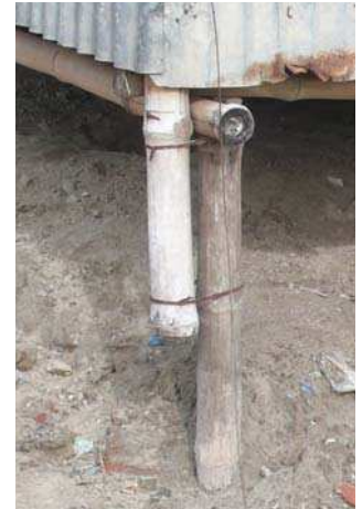
Bangladesh fixation poteau-pilotis changeable système parainondation
