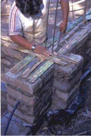
El Salvador renforcement horizontal système parasismique
