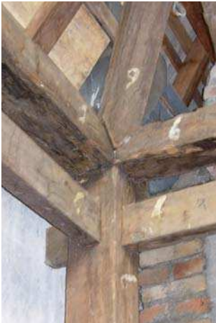
Indonésie connexion poteau-charpente système parasismique
