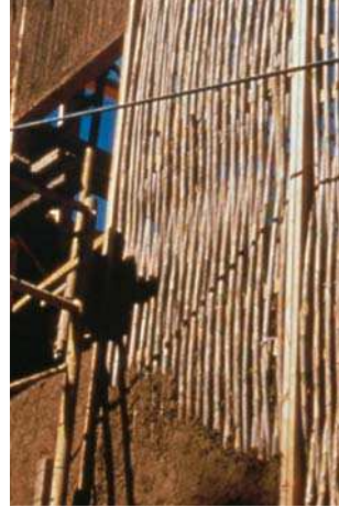
El Salvador mur en bambou et terre système parasismique
