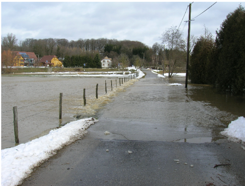
Gué de la Largue à Altenach permettant le stockage des eaux dans un nouveau champ d'inondation (Source : L. With)
