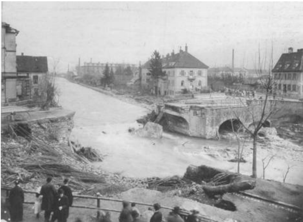
Destruction du pont de la Porte de Souabe à Freiburg, mars 1896. (Source : Stadtarchiv Freiburg)
