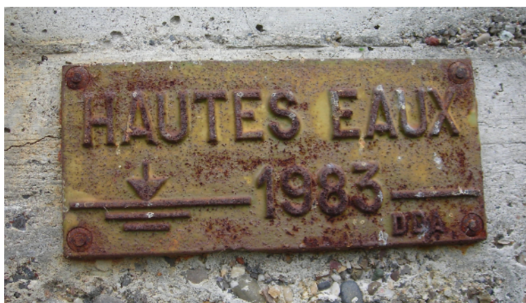
Pont de la Largue à Altenach (Source : L. With)
